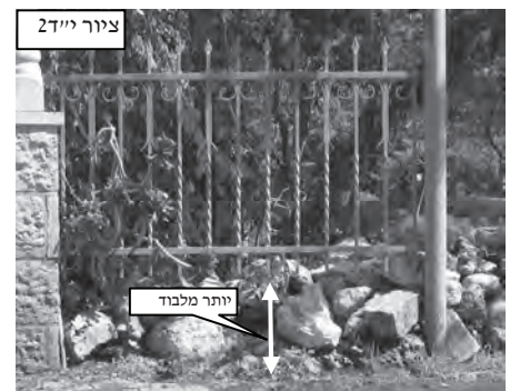
יכולים לבקוע תחתיה. [ובמקום שאין אבנים כבדות וכדו' נוהגים להוסיף מוט ברזל אופקי לציור "לבוד" בין הגדר לקרקעית ובשעת הדחק מסתפקים בקשירת חוט עד שיתקנו את הדבר ע"י בעל מלאכה].
